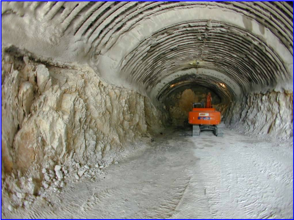
Fase realizzativa serbatoio in caverna da 15.000 mc. in località Monte Pizzuto di Solopaca (Bn)
