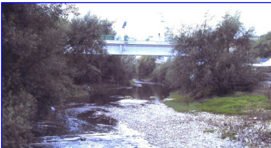
Stazione idrometrica sul fiume Sabato
